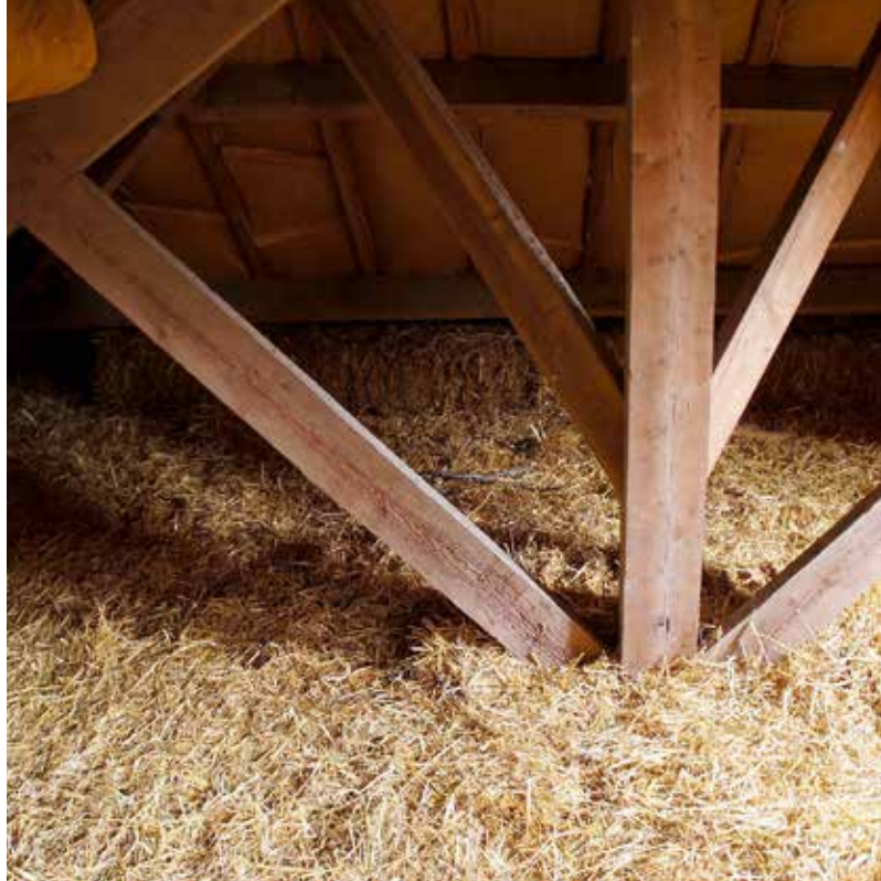
Bardage extérieur issu de forêts manchoises, isolation avec de la paille dans les combles perdus : Charlotte a privilégié des matériaux locaux pour la rénovation thermique de sa maison, à Donville-les-Bains. Photos : © C. Lecoustey
